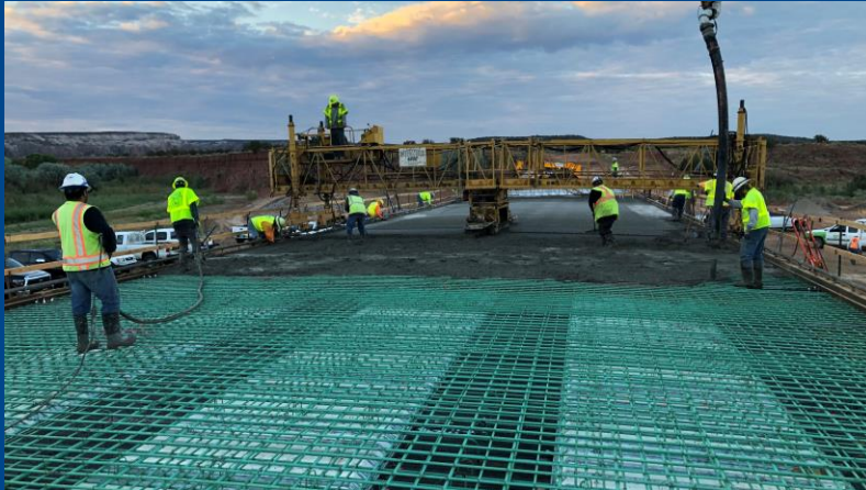
Early Morning Concrete Deck Pour
